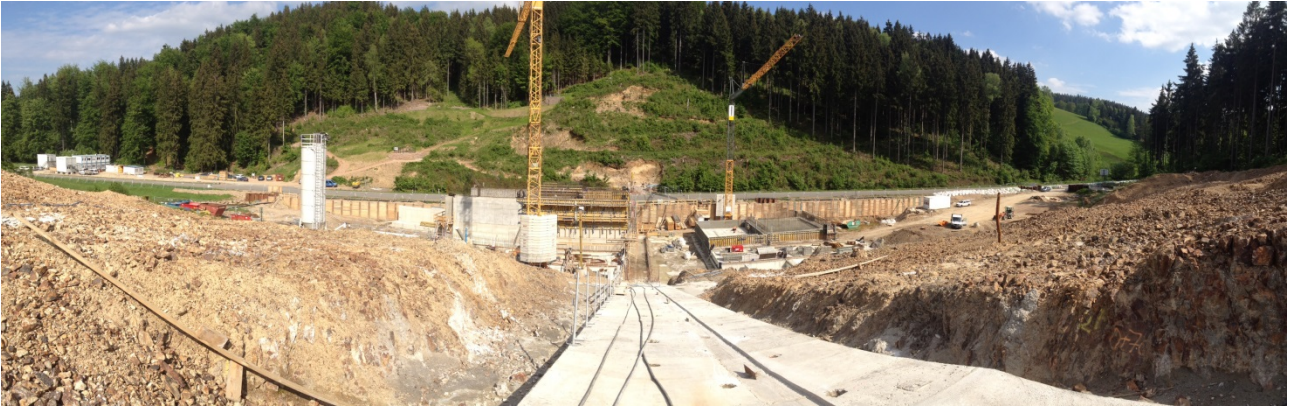
Bild 3 Blick über die Herdmauer auf das Durchlassbauwerk in Talmitte und den linken Hang mit Fledermausstollen (hinter dem linken Kran) – Bildquelle: Pohl
