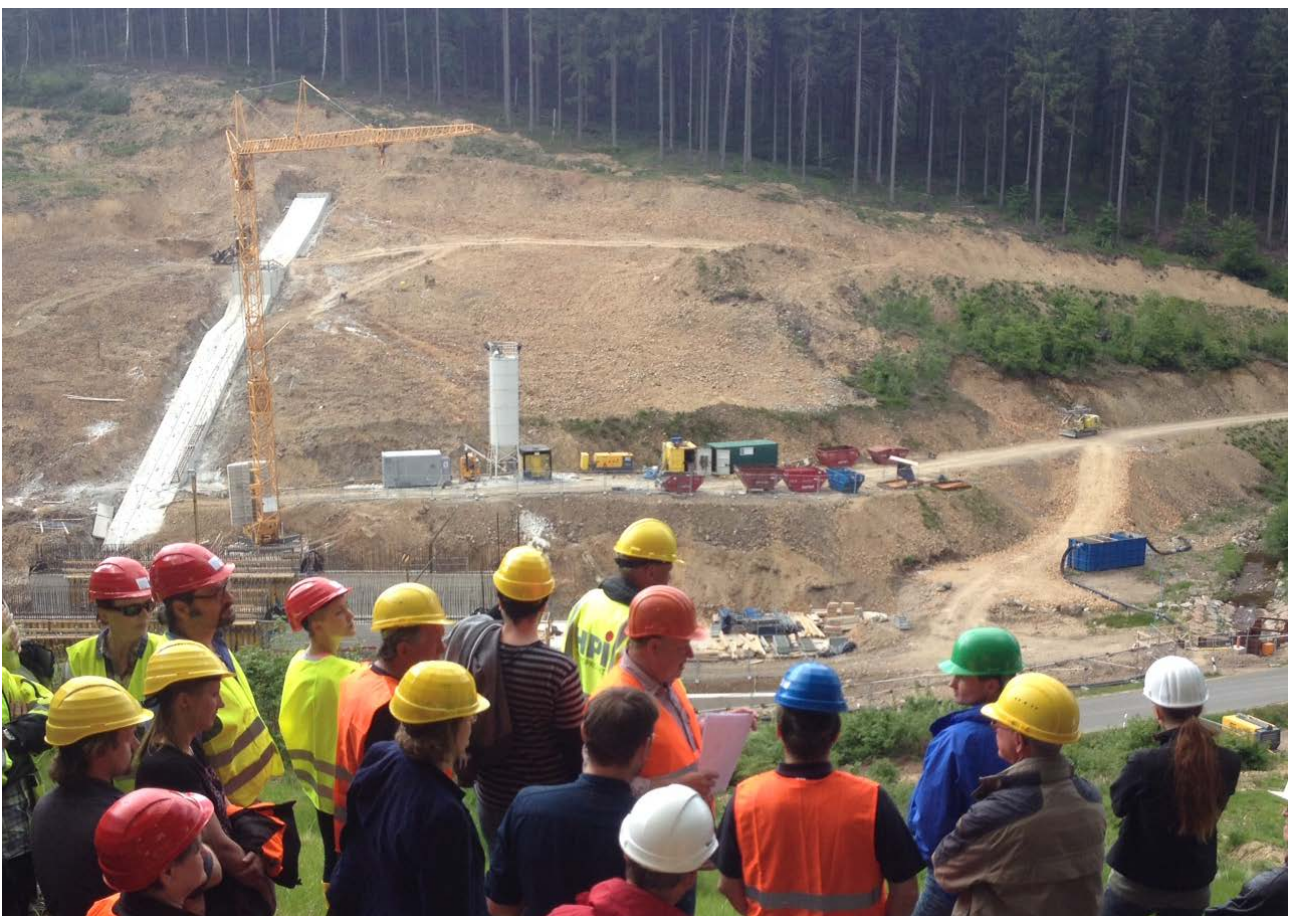
Bild 2 Blick vom rechten Hang auf die fertiggestellte Herdmauer und Dammaufstandsfläche – Bildquelle: Pohl
